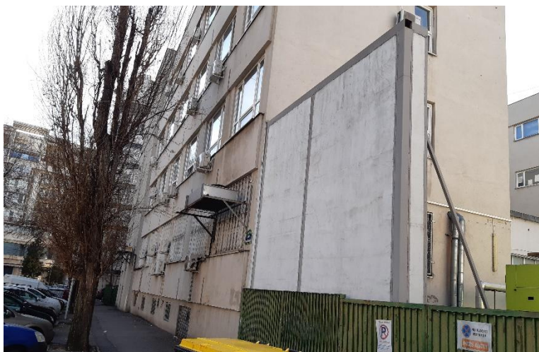
Foto 1 Barieră pentru protecția la zgomot
